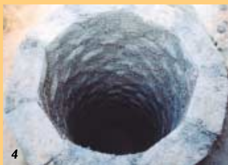
(1) Fabrication du moule pour la dalle avec un modèle en fer et une base de sable. (2) Coffrage de la dalle avec du béton armé et des barres de fer. (3) Latrine finie. (4) Fosse creusée à 4 mètres et revêtue de blocs de boue. (5) Fosse plâtrée avec du ciment et prête pour l'installation de la dalle.
