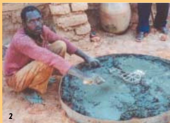
(1) Fabrication du moule pour la dalle avec un modèle en fer et une base de sable. (2) Coffrage de la dalle avec du béton armé et des barres de fer. (3) Latrine finie. (4) Fosse creusée à 4 mètres et revêtue de blocs de boue. (5) Fosse plâtrée avec du ciment et prête pour l'installation de la dalle.
